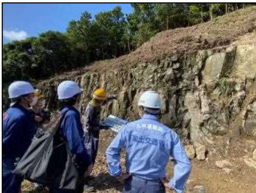
【現地での被害状況確認】
